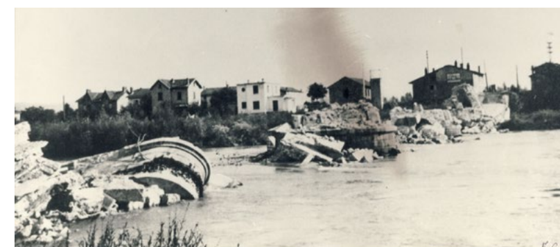
31.08.44. Pont d'Ain, pont routier RN 75, vu du quai Justin Raymond
