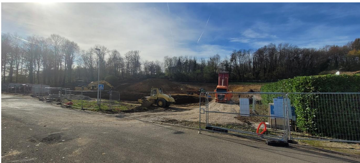
Forage des têtes d'inclusion sur un matelas de répartition (Décembre 2025) :
