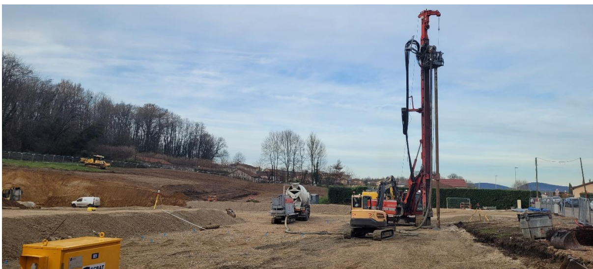
Forage des têtes d'inclusion sur un matelas de répartition (Décembre 2025) :
