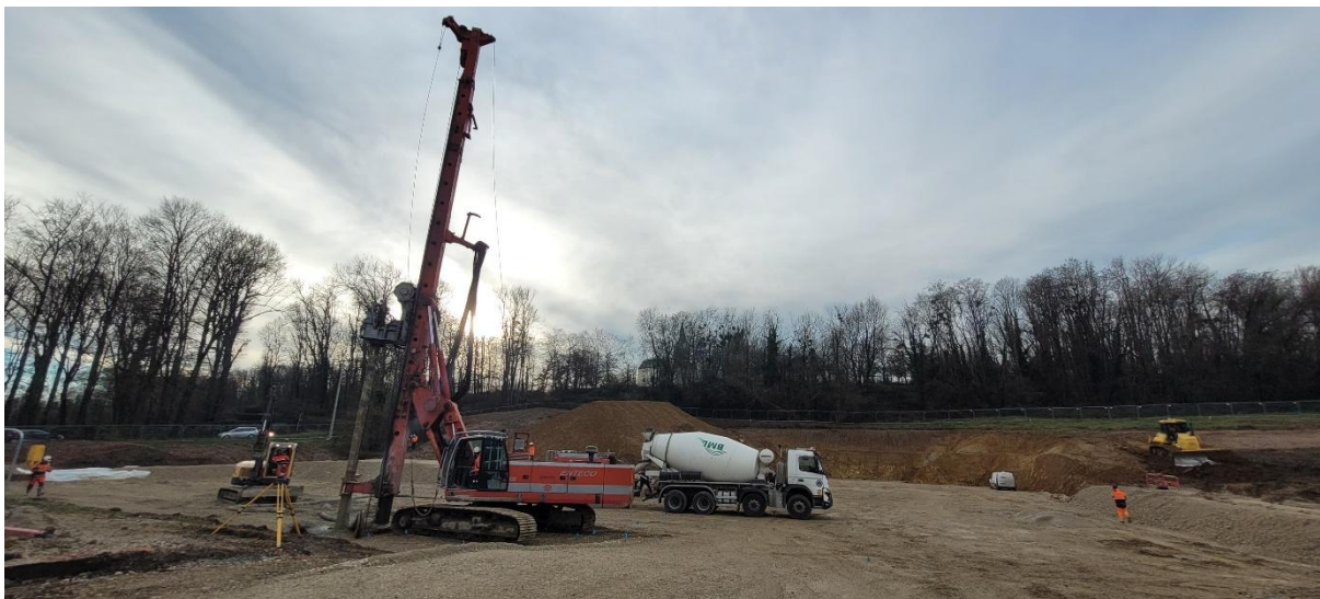
Préparation du socle pour la pose de la grue (22 décembre 2025) :
