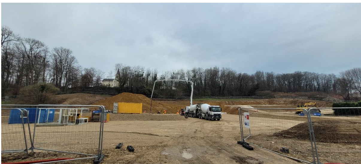
Préparation du socle pour la pose de la grue (22 décembre 2025) :
